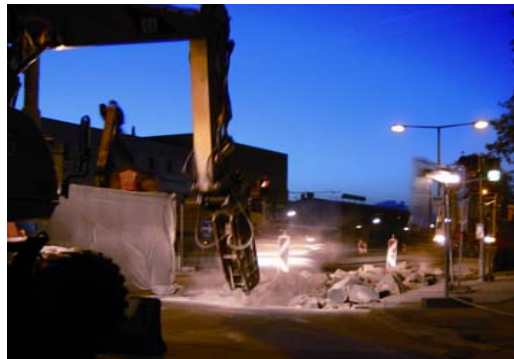
Rivning av betongslitlager i Wien
